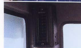
▲上部吹き出しクーラー(右後方)
