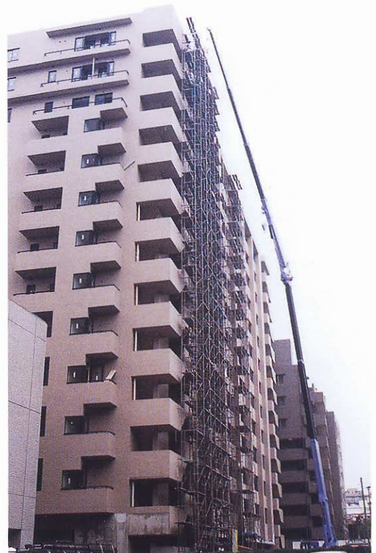
13階建マンション屋上への資材運搬。
