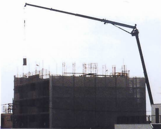
RC造マンション PC壁の取付作業。
