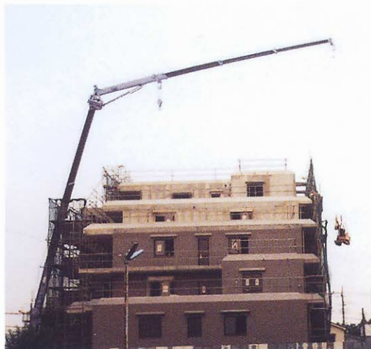
6階建マンションの山越え作業。(8階建まで対応可能)
