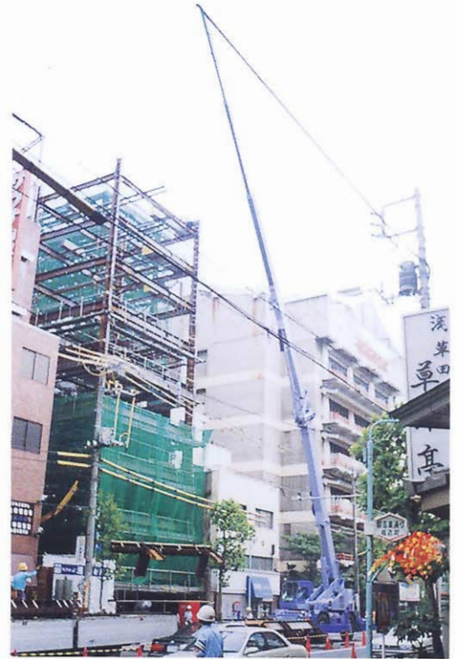
SRC造マンション 鉄骨柱の荷取作業。
