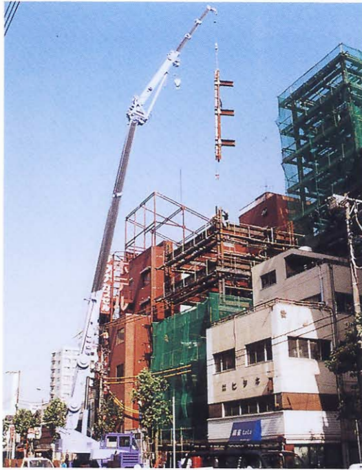
SRC造マンション 鉄骨柱の建方作業。
